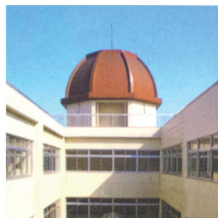
完成直後の現 八角塔
