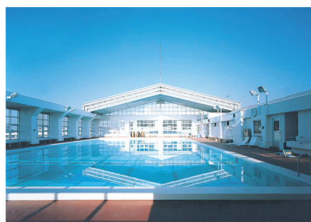
屋根開閉型プール
