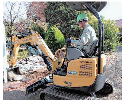
総合実習（重機操作）
