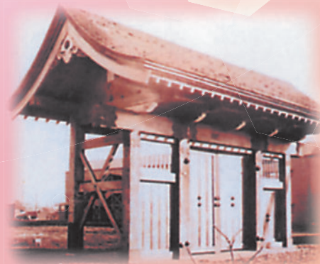
昭和25年 現在地に落成した正門
