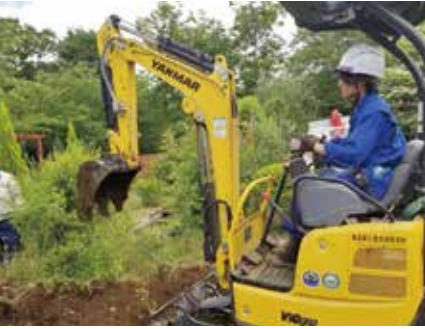
総合実習 重機操作
