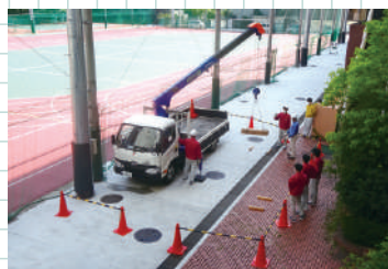
▲移動式クレーン運転・玉掛特別講習
